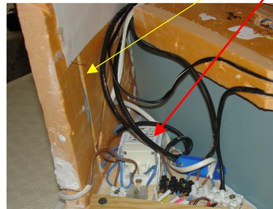
La reactancia se pone detrás del espejo E3 y los cables se disimulan en el poliestireno, por detrás de la cartulina celaje
