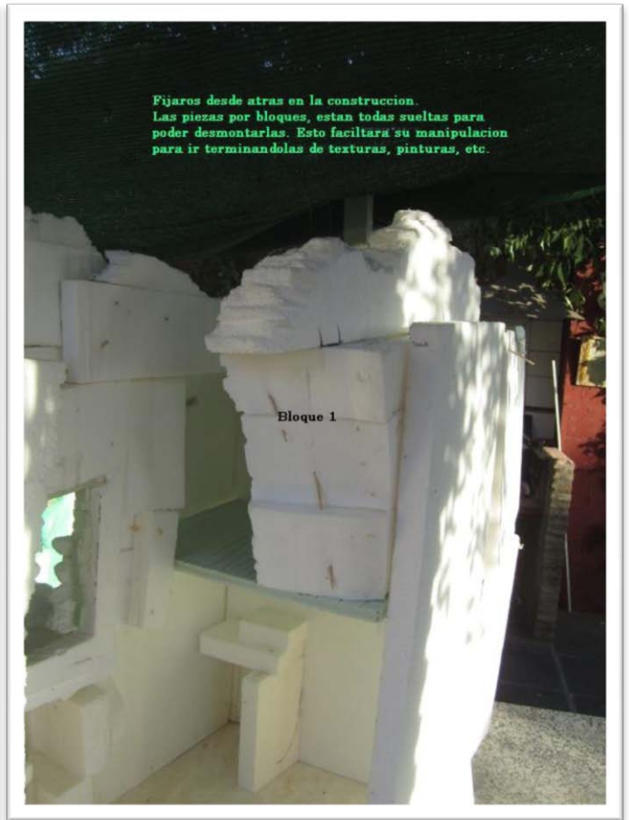
Fijaros desde atrás en la construcción. Las piezas por bloques están todas sueltas para poder desmontarlas. Esto facilitará su manipulación para ir terminándolas de texturas, pinturas, etc.
